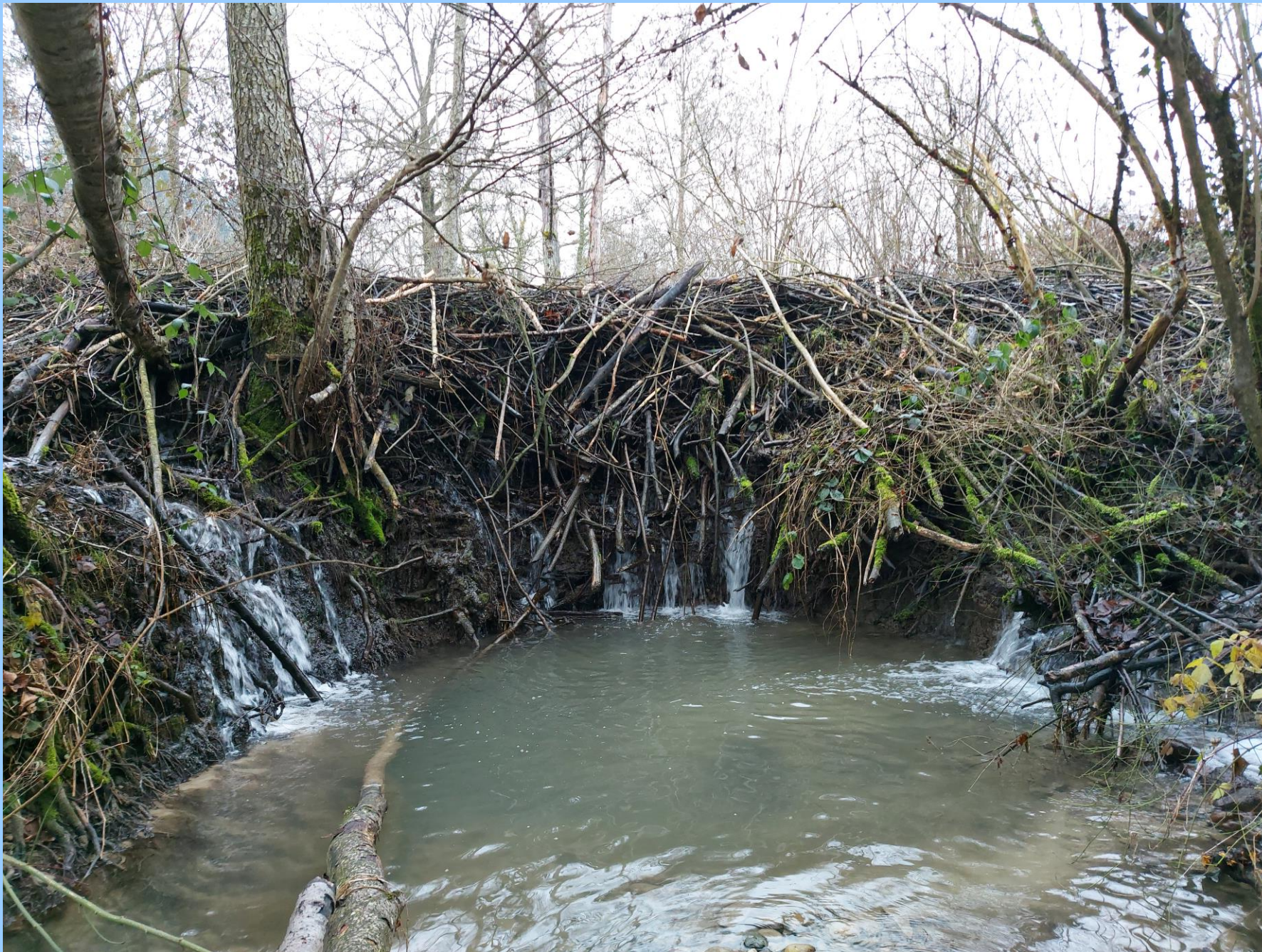
Über 2m hoher Biberdamm am Marfeldingerbach Gem. Mühleberg, 21.12.2020
