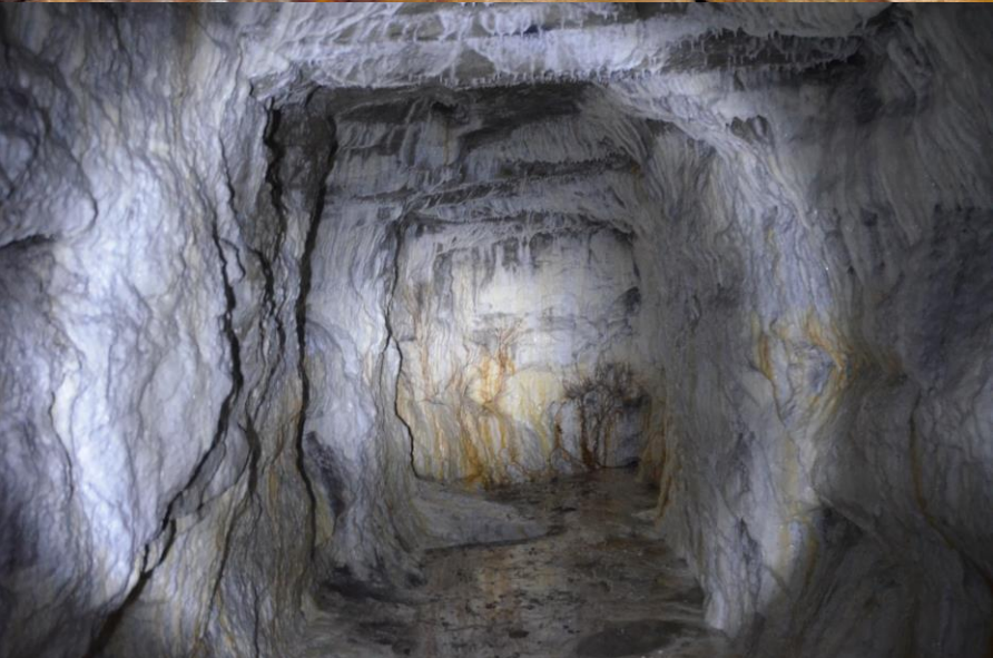
Überwinterungsstollen am Bantiger
